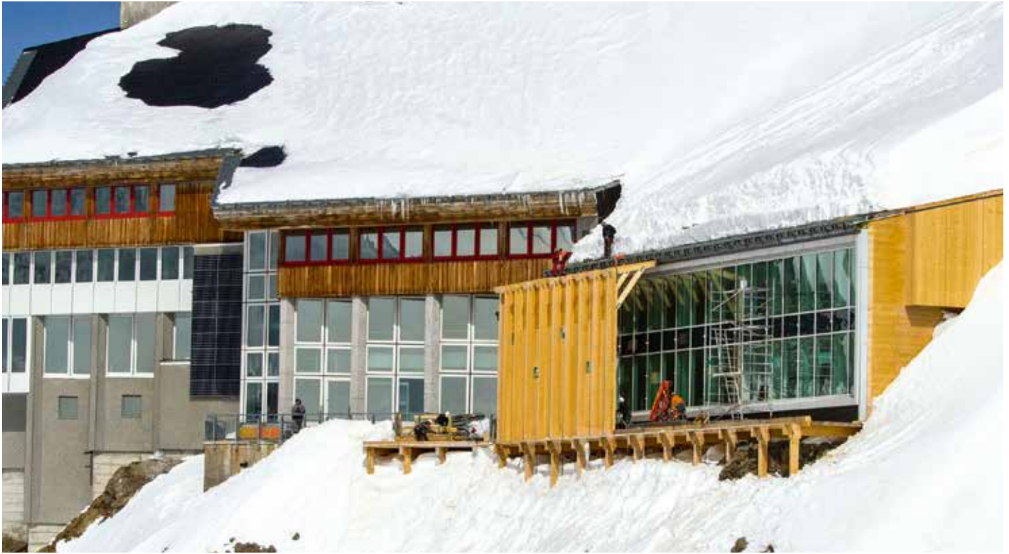
So sieht die neue Glasfassade des Gletscherrestaurants auf dem Jungfrauoch aus. Wegen Temperaturen bis minus 30 Grad musste ein Schutzhaus erstellt werden.
